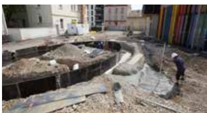
Travaux du groupe scolaire Marcellin-Berthelot
