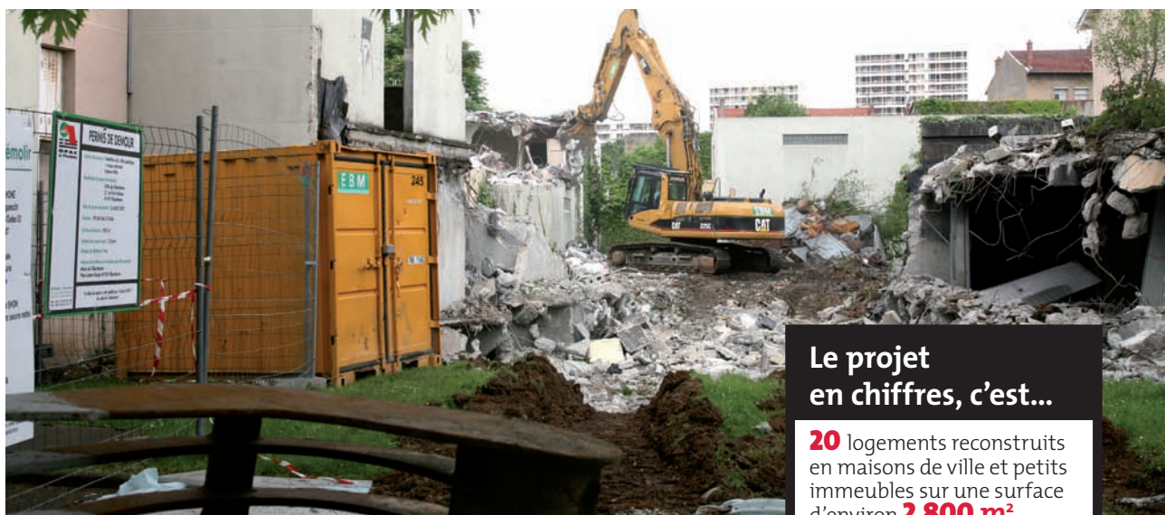
Été 2008 : travaux de démolition des 12 villas.
