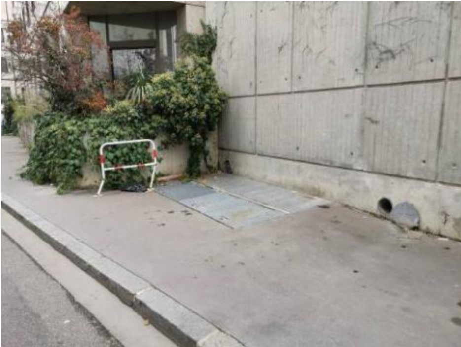
Emplacement du forage de prélèvement sur trottoir – rue de Genève
