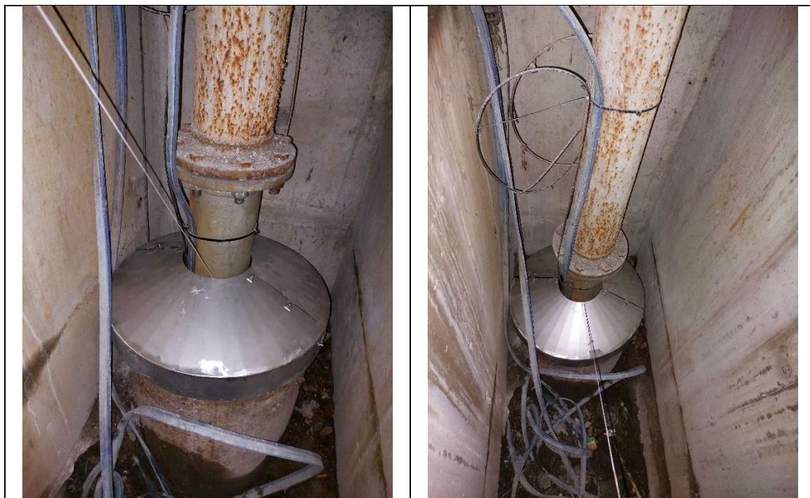
Deux demi-cloches installées en tête du forage de prélèvement
