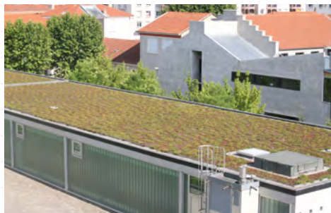
Toiture végétalisée - École A. Perrin
