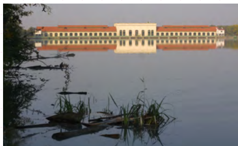
L'usine hydroélectrique de Cusset
