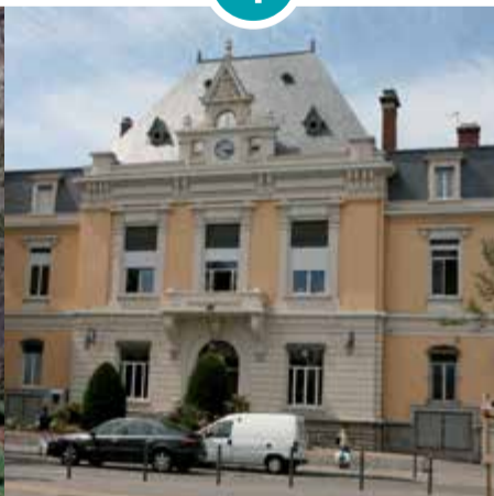
Ancienne mairie devenue le bâtiment de la Poste
