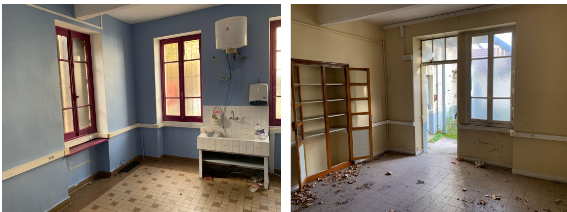
Photos avant travaux de réhabilitation pour l'OT
