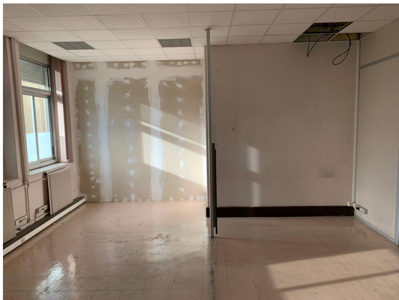
Photos avant travaux de réhabilitation pour l'OT
