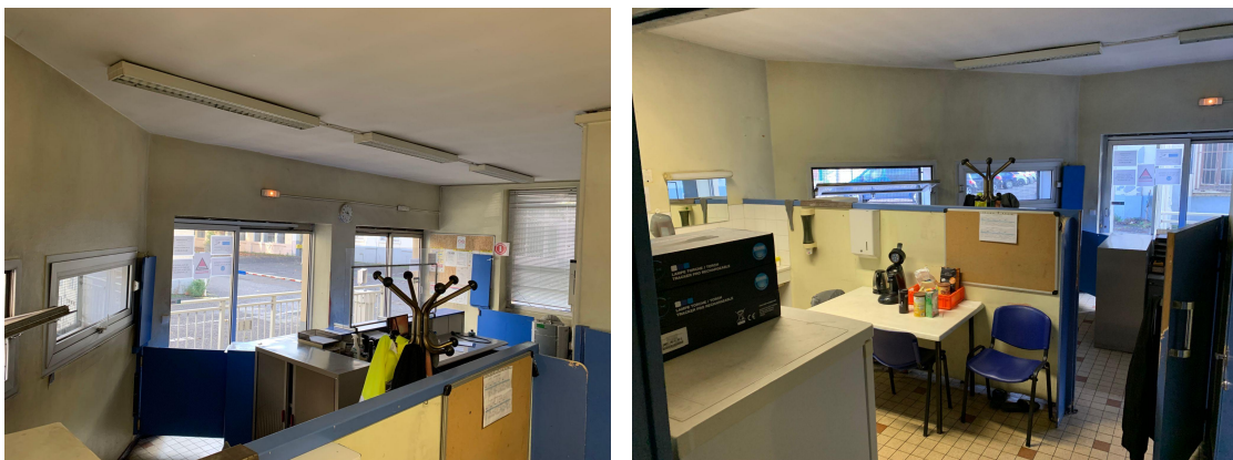
Photos avant travaux de réhabilitation pour l'OT
