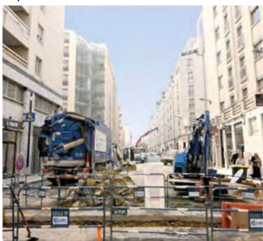
Travaux de dévoiement de réseaux rue Verlaine
