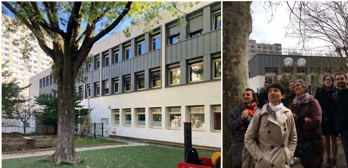
Le 11 mars 2022, le Tour de France de la rénovation énergétique des bâtiments publics faisait escale à Villeurbanne, en partenariat avec le SIGERLy. L'occasion pour la Ville de présenter les travaux de réfection du groupe scolaire Louis-Armand.
